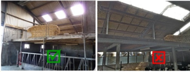
Foto Zolder met afscherming en open zolder
